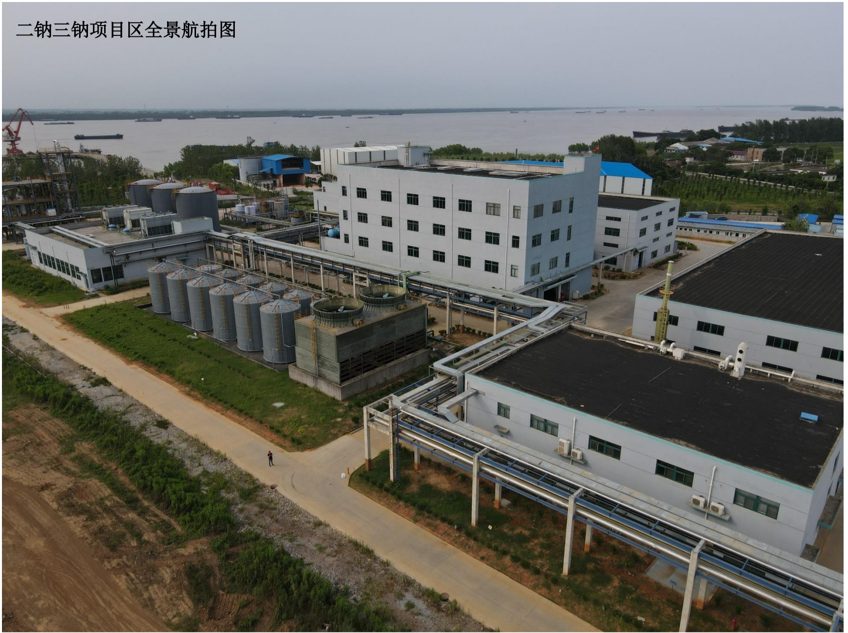
邻二技改项目航拍图（制氢加氢车间）
