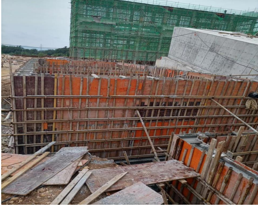
正在建设中的三级沉淀池
